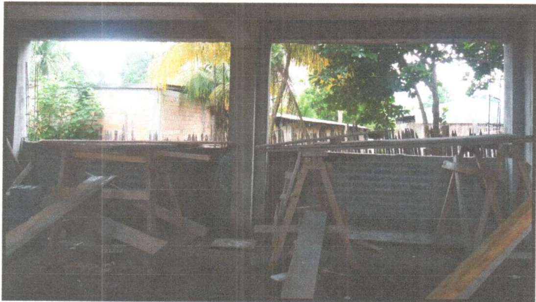
FOTO N°06: MURO DE LADRILLO KK TIPO IV SOGA. MODULO 02.
