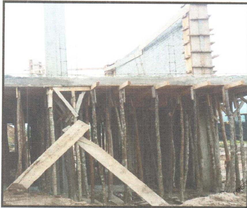
FOTO N°05: CONCRETO, ENFRADO Y DESENCOFRADO DE COLUMNAS SEGUNDO NIVEL. MODULO 02.
