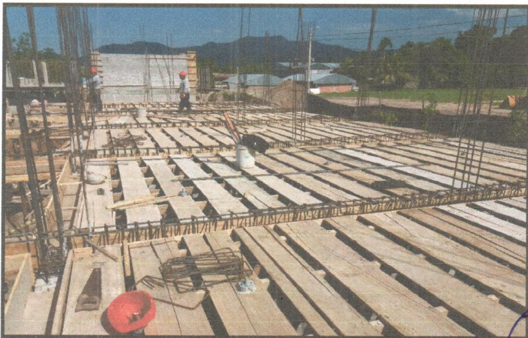
FOTO N°01: ENCOFRADO DE VIGAS. MODULO 01
