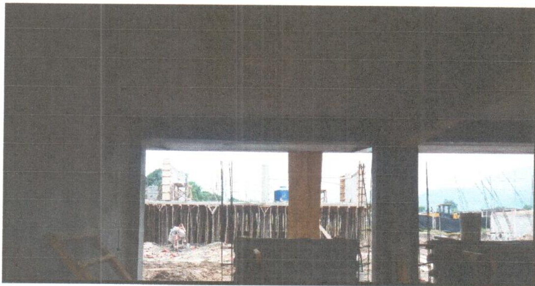
FOTO N°12: TARRAJEO EN MURO INTERIOR Y CIELO RASO CON MEZCLA. MODULO 04
